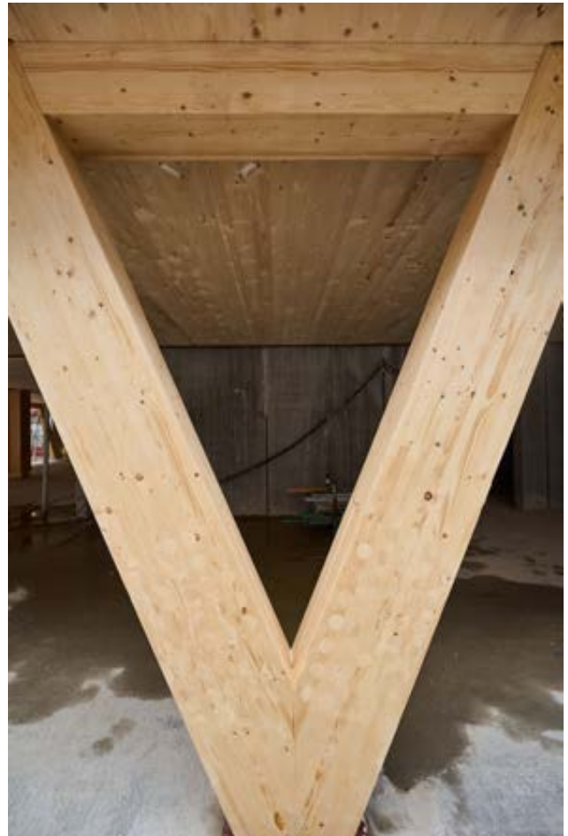
► Detail van de innovatieve houten structuur van het kantoorgebouw Montoyer 10 - Brussel CBD (BE)
