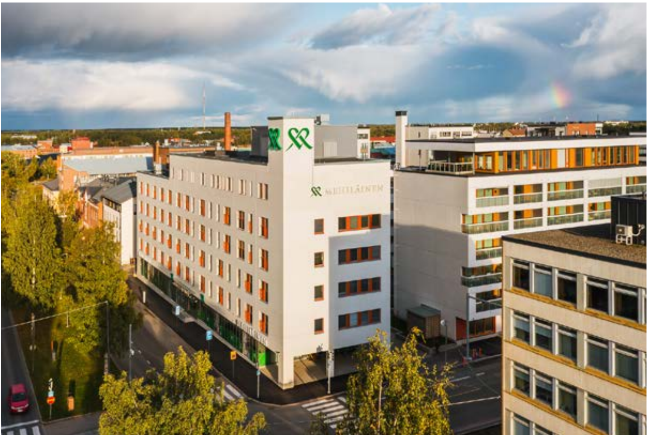
► Eerstelijnszorgcentrum - Vasaa (FI)
