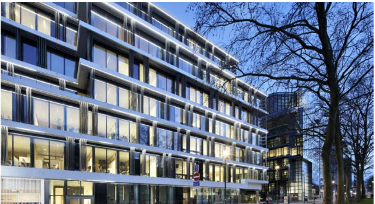
► Kantoorgebouw Quartz – Brussel CBD (BE)
