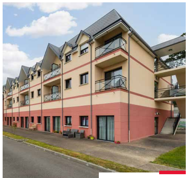
Woonzorgcentrum Nouvel Azur – Saint-Pierre-du-Regard (FR)
