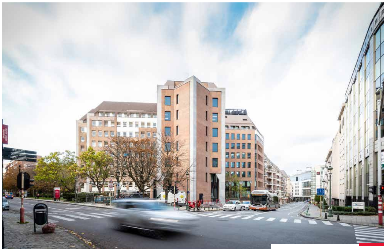
Kantoorgebouw met een medisch centrum Troon 100 – Brussel CBD (BE)
