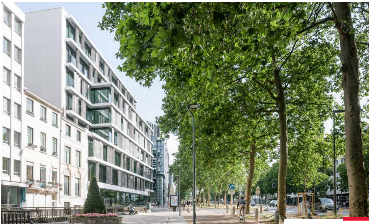
Kantoorgebouw Quartz – Brussel CBD (BE)
