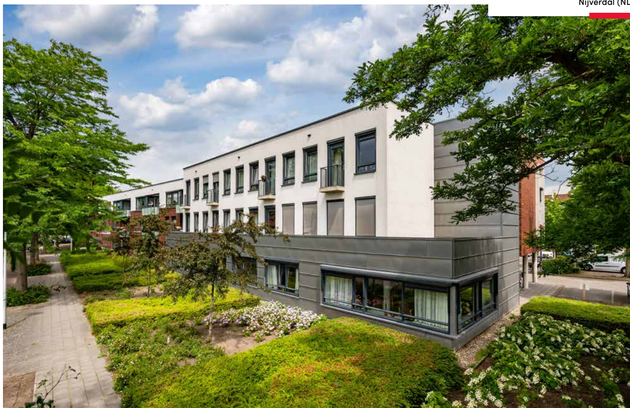
Woonzorgcentrum De Parallel – Nijverdal (NL)
